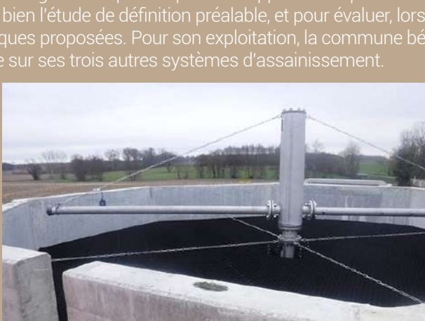
De gauche à droite : arrivée des eaux dans un dégrilleur automatique, passage dans le lit bactérien et répartition sur les filtres.
