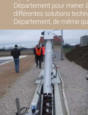
De gauche à droite : arrivée des eaux dans un dégrilleur automatique, passage dans le lit bactérien et répartition sur les filtres.
